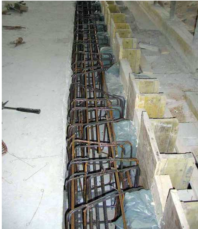
مهار آرماتورهای کف جدید در دیوارهای بنایی.
