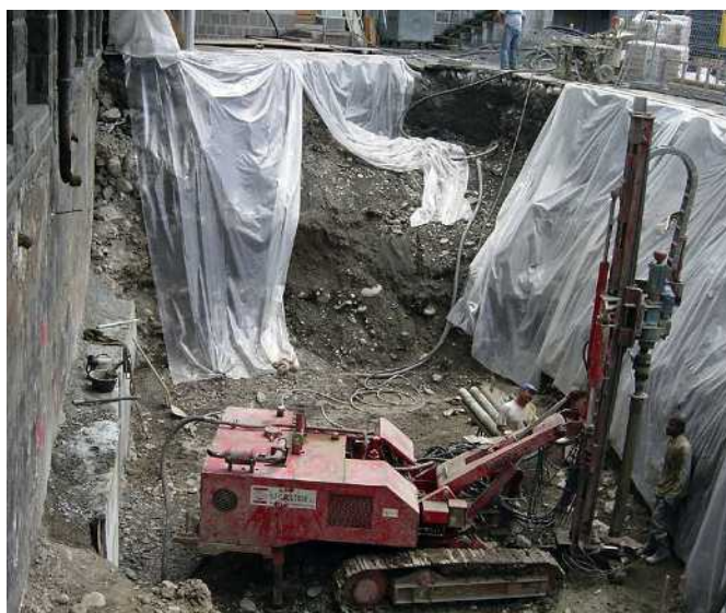
اجرای شالوده شفت بتن مسلح جدید متکی بر ریزشمع.
