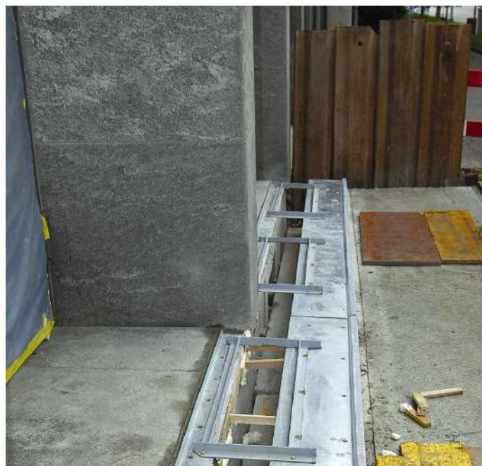
تعییه درز انبساط در اطراف ساختمان حرکت افقی بالیستک‌های لرزه‌ای جدید را ممکن ساخت.
