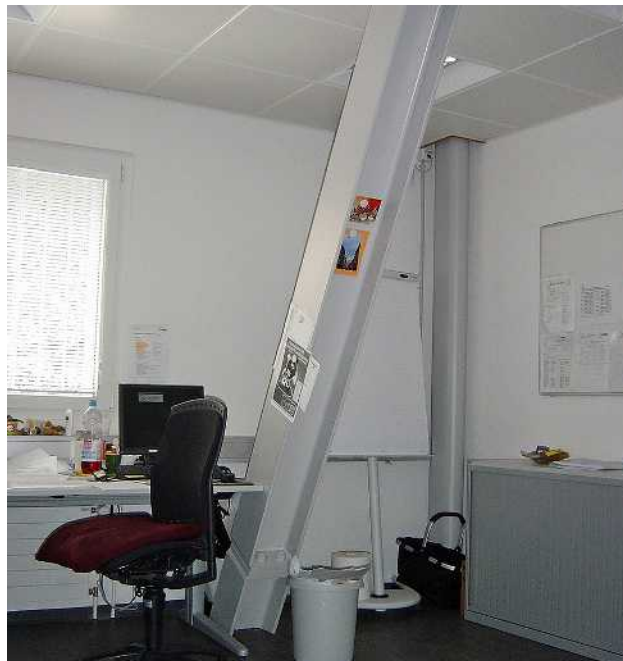
عضوی از خرپای فولادی V شکل جدید در اتاق اداری طبقه همکف.
