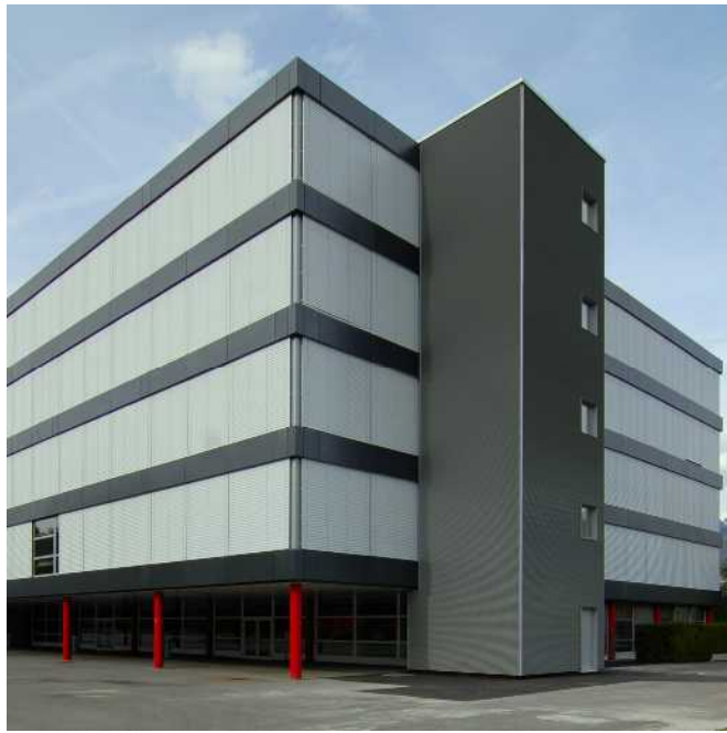
نمای برج پلکان جدید در وجه جنوبی ساختمان.
