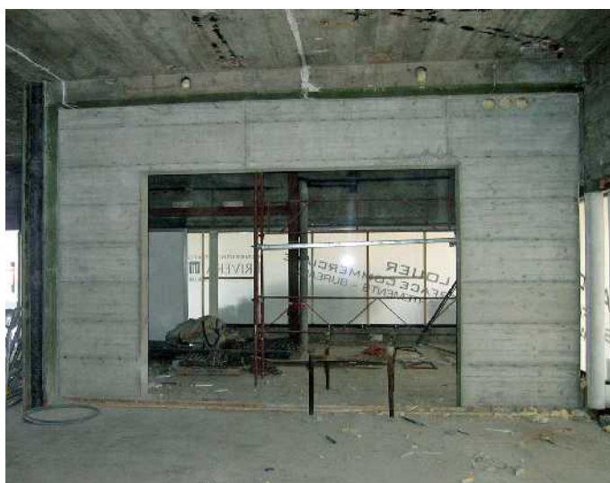
قاب بتن مسلح جدید در طبقه همکف.
