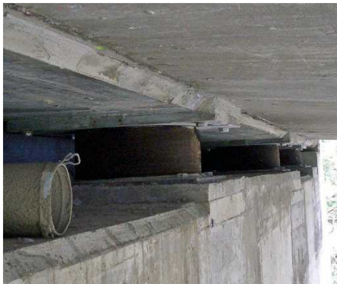
نصب بالشتک‌های لاستیکی با میرایی زیاد در کوله‌ها.
