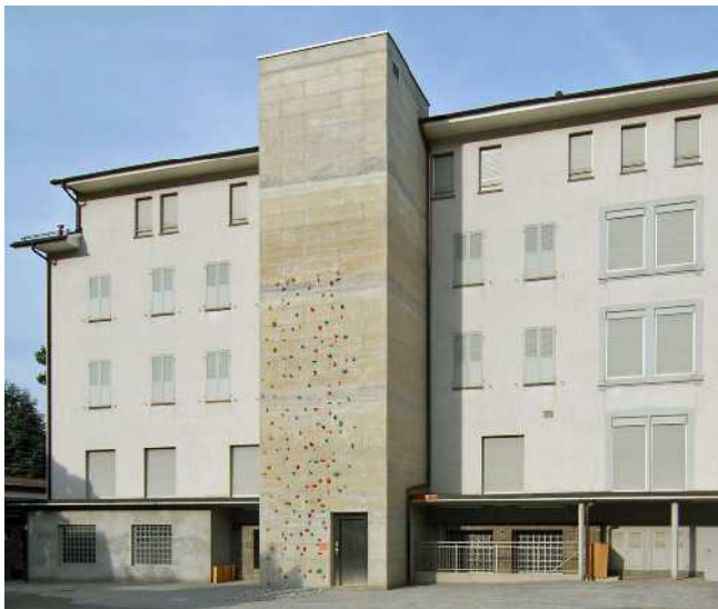
نمای دیوار پشتی ساختمان به‌همراه شفت بتن مسلح جدید.
