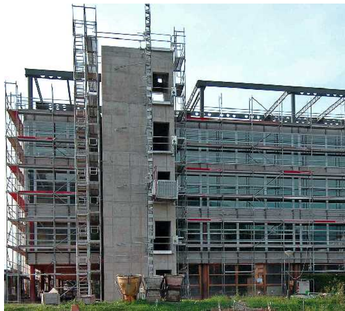
برج پلکان جدید و طبقه جدید ساختمان در حال اجرا (سمت جنوب).
