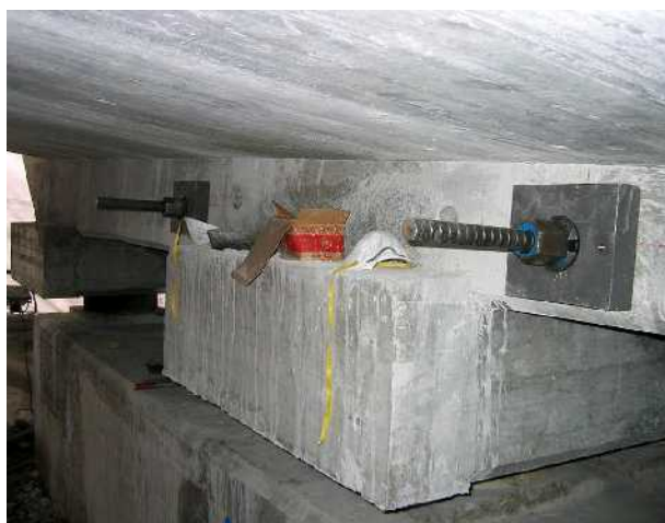
یکپارچه نمودن دو نیمه پل در محل درز انبساط موجود بر روی دهانه میانی.
