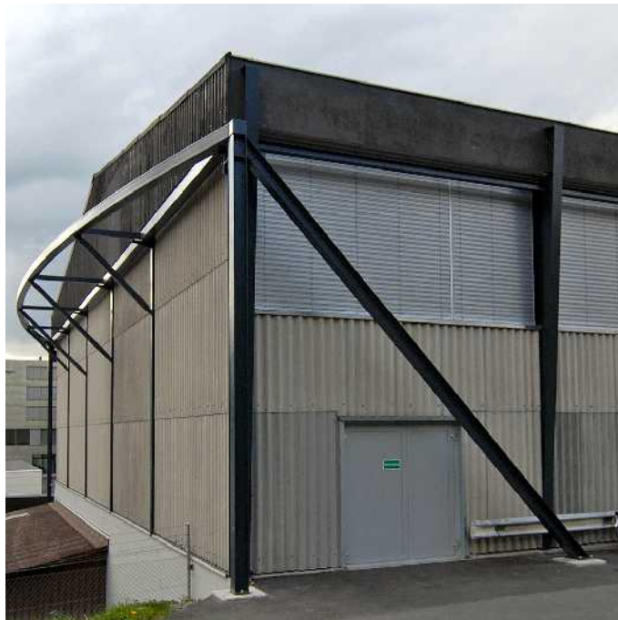
تقویت در امتداد طولی با خرپای افقی شکم ماهی متکی بر وال‌پست‌های انتهایی.
