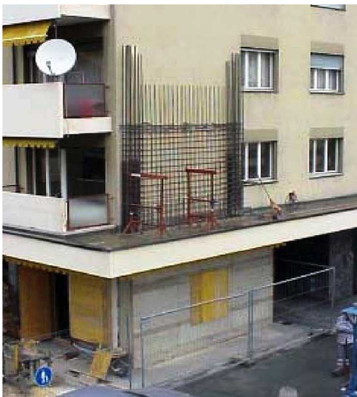
دیوار پیرامونی جدید بتن مسلح که در جلوی دیوار موجود بتن‌ریزی و اجرا می‌گردد.
