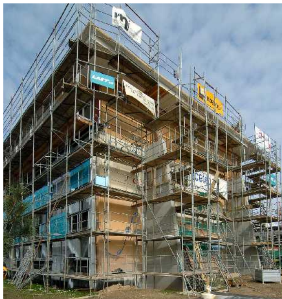
عملیات اجرای دو پشت‌بند بتن مسلح مثلثی در نمای جنوبی ساختمان.
