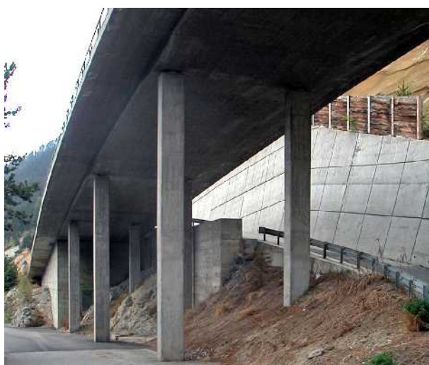
نمای بخشی از پل با پایه‌های بلند و لاغر.
