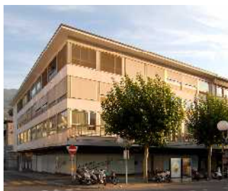
ساختمان با طبقه همکف نرم (مثال ۱۵: ساختمان مسکونی و فروشگاه در شهر سیون)
